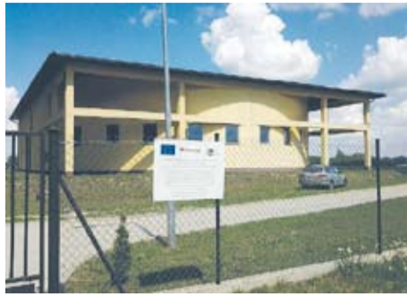
Budynek oczyszczalni ścieków powstałej według innowacyjnej technologii w gminie Świercze w powiecie pultuskim
